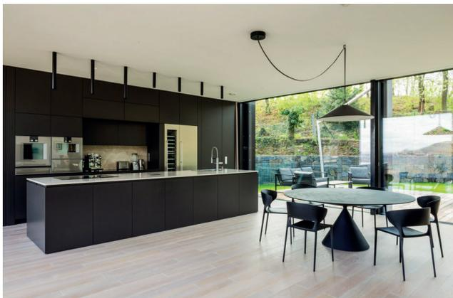
6\_Die überdurchschnittliche Grösse der Schiebeelemente liegt bei 4 x 3 Metern.
