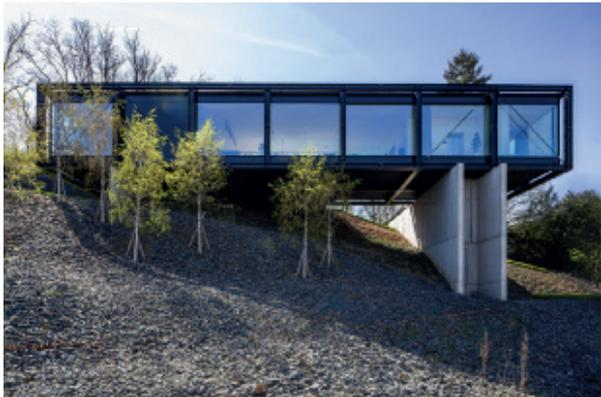
1\_Gestützt wird der rechteckige Kasten aus Stahl und Glas von massiven Stahlbetonpfelern und Glas
