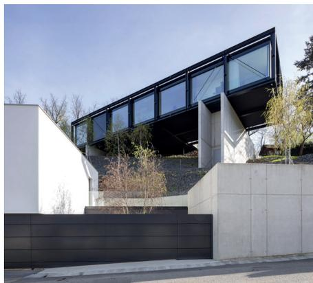
4\_Die Breite der Glaselemente sollte exakt mit den Stahlträgern der Grundkonstruktion synchronisiert werden
